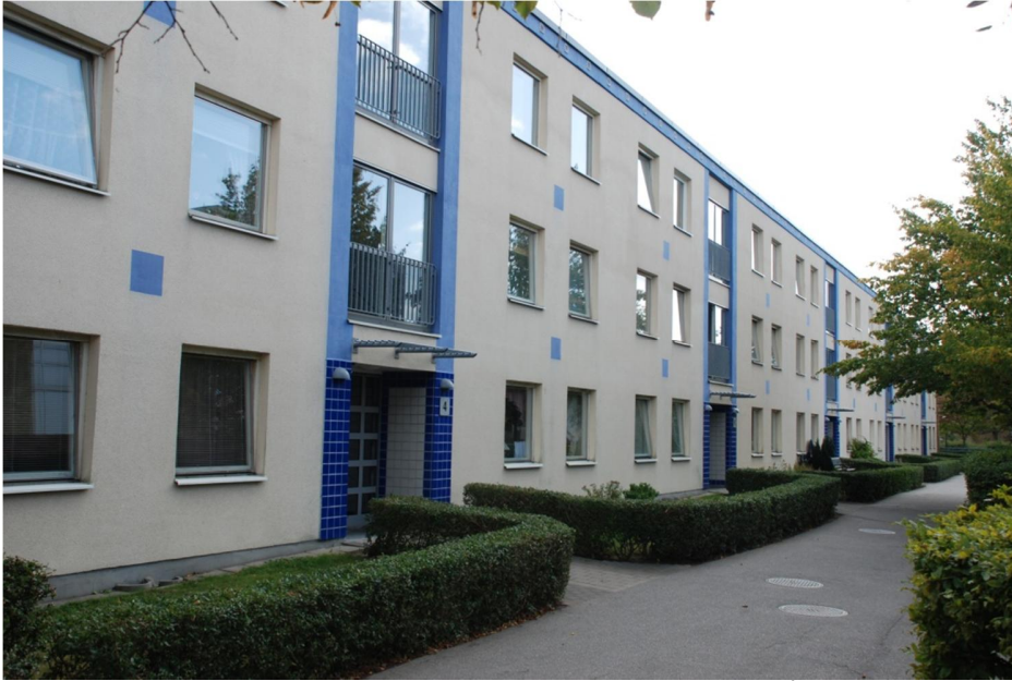
Figur 7.1 Flerbostadshus före ombyggnad i Malmö (foto Åke Blomsterberg).
