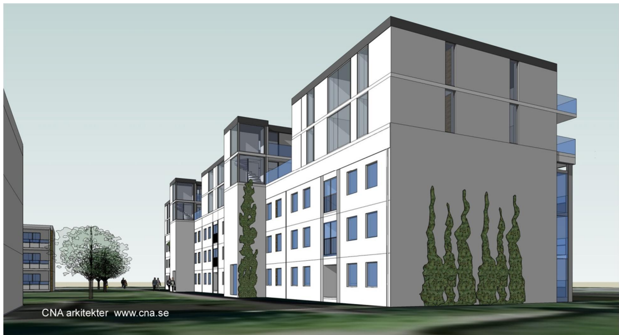
Figur 7.12 Påbyggnad, ny klimatskärm och två nya trapphus med hiss på utsidan av den befintliga byggnaden (bild Christer Nordström).
