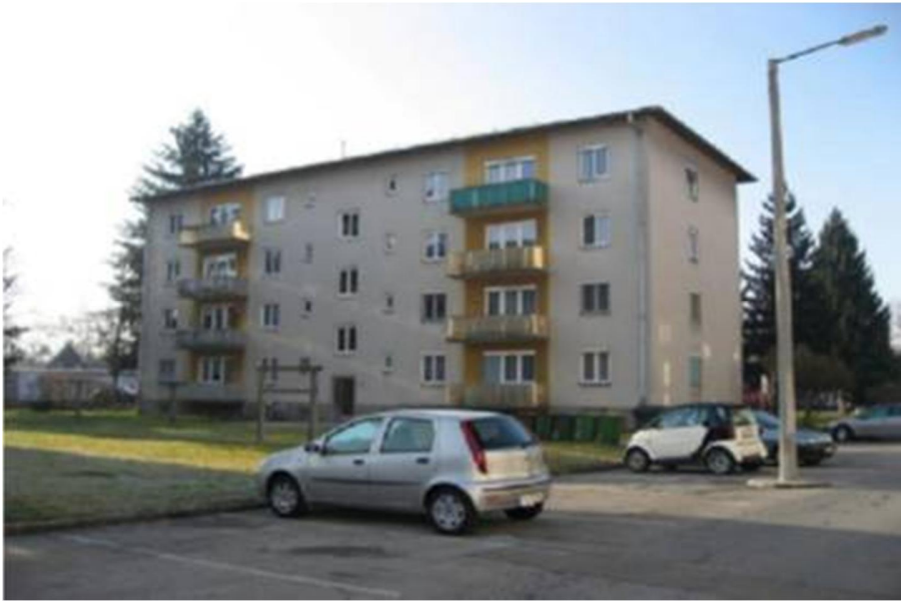
Figur 4.5 Flerbostadshus före ombyggnad, Dieselweg 4, Graz Österrike.
