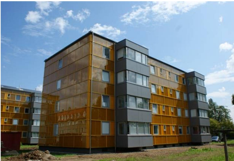
Figur 4.6 Flerbostadshus efter ombyggnad, Dieselweg 4, Graz Österrike.
