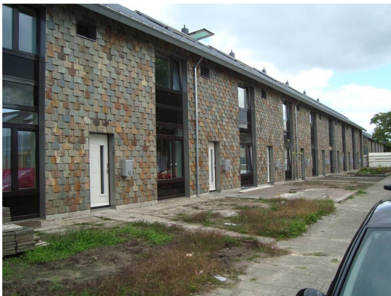
Figur 6.2 Flerbostadshus efter ombyggnad i Nederländerna.
