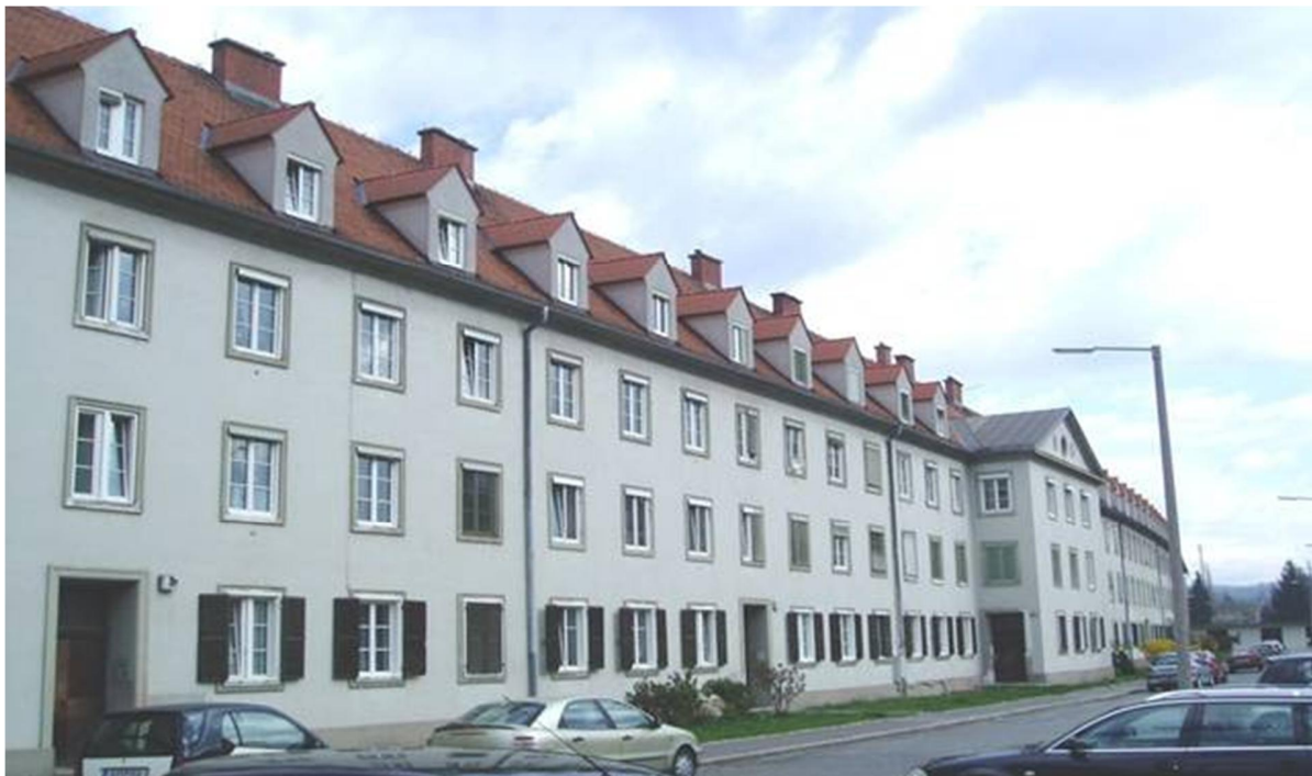
Figur 4.1 Flerbostadshus före ombyggnad, Dieselweg 3-19, Graz Österrike.
