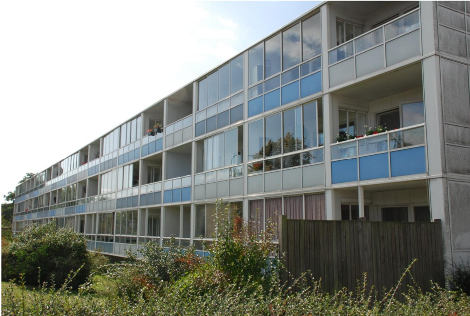
Figur 7.2 Flerbostadshus före ombyggnad i Malmö (foto Åke Blomsterberg).
