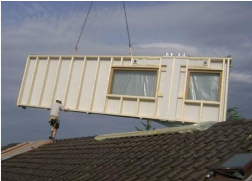
Figur 5.3 Montering av upp till tolv meter långa fasadelement.
