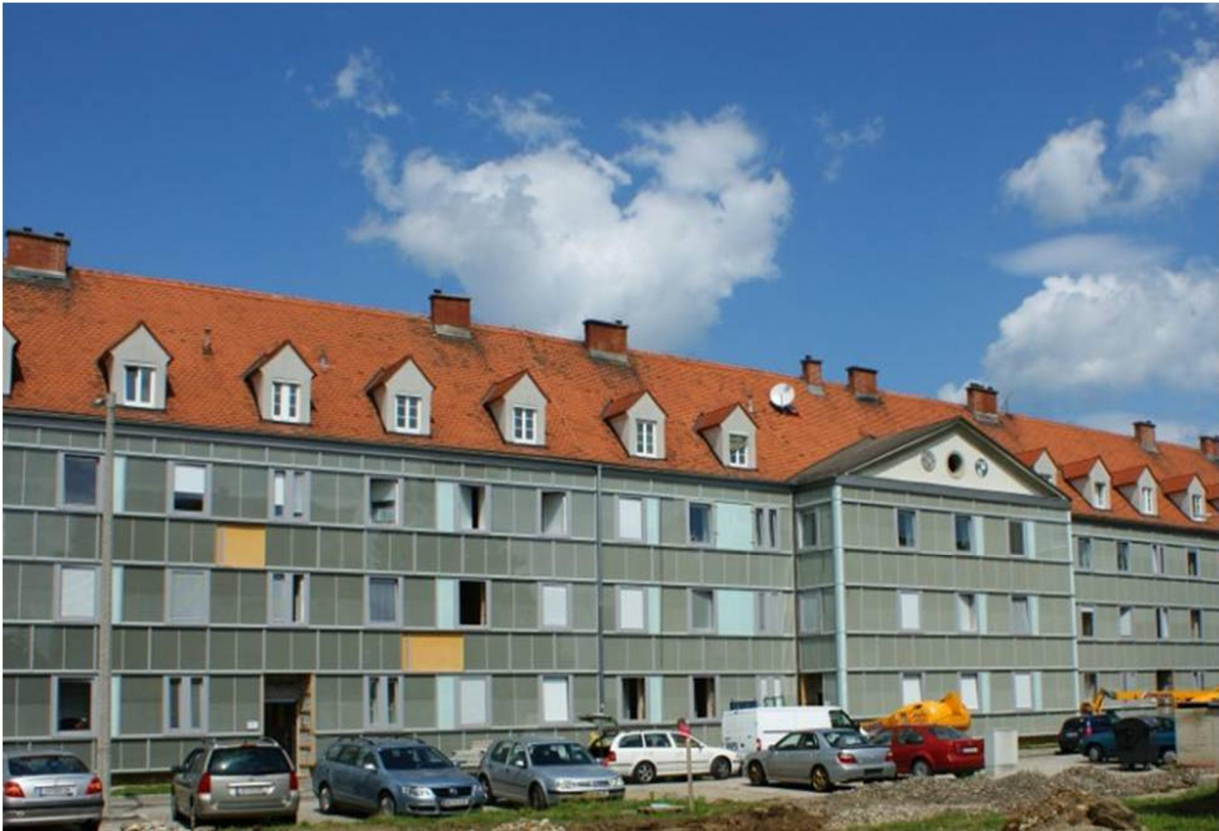
Figur 4.3 Flerbostadshus efter ombyggnad, Dieselweg 3-19, Graz Österrike.
