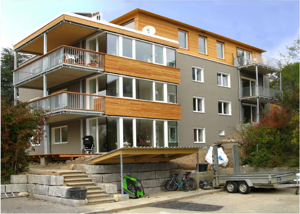
Figur 5.2 Flerbostadshus efter ombyggnad i Zürich, Schweiz.
